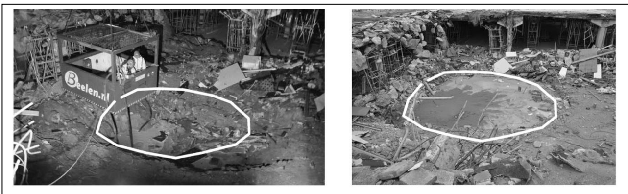
Abb.6 : Einfüllen der Dämmersuspension vom Fahrkorb und verfüllter Tagesbruch [1]
